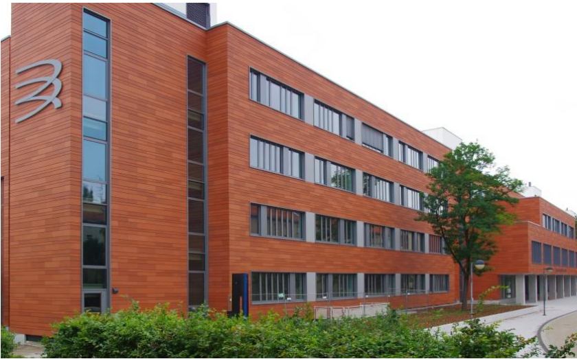
Abb. 3 nach der Fassadensanierung 2012
