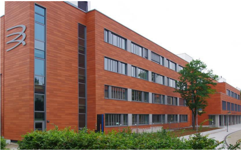
Abb. 3 nach der Fassadensanierung 2012
